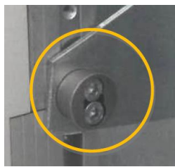
Abb. 56 Lagerbolzen mit Schrauben LB 18-2-SL13-2xM5x16.
